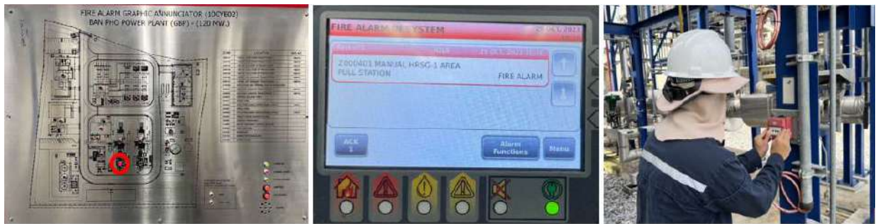
Fig.12 : Test manual call point at HRSG area
